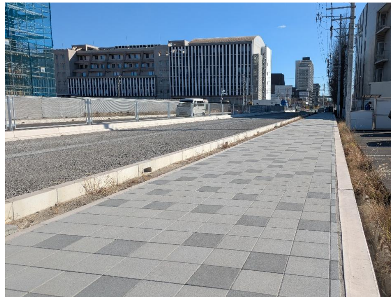
低炭素型コンクリート使用ブロック：東海太田川駅（愛知県東海市）
